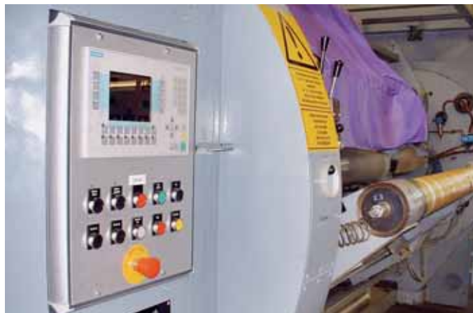
Abb. 2: Auch eine neue Visualisierung mit einem Operator-Panel gehörte zu den Arbeiten.
